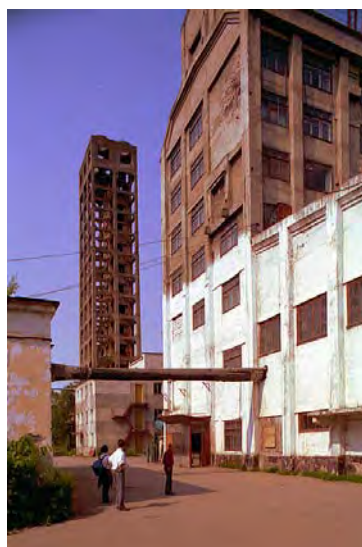
写真3: 旧王子製紙豊原工場 木釜室・製薬塔(1996年撮影)
